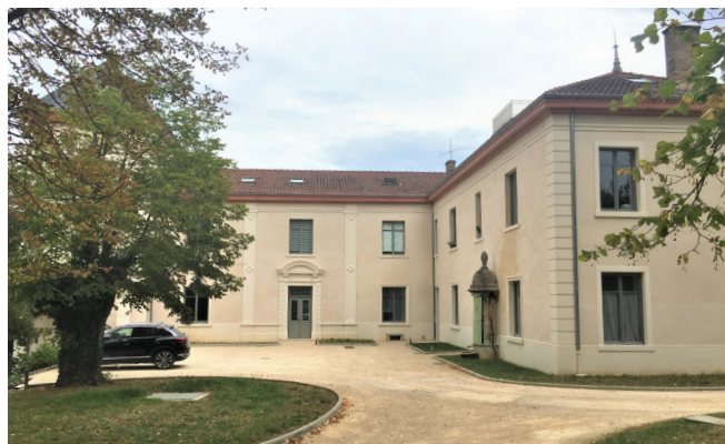
▲ Transformation de la propriété La Malmaison (ex-fondation Bullukian) en 18 logements, Champagne-au-Mont-d'Or (69)
