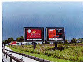
Dispositifs en « doublon » sur scellés au sol
