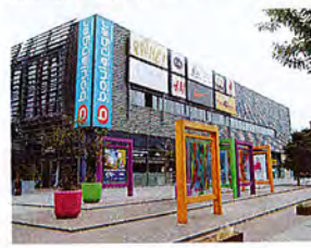
Un exemple intéressant de mutualisation et d'harmonisation des enseignes en façade : leurs dimensions sont similaires, leur format rectangulaire, pas d'obstruction des bords, elles sont alignées et ne dépassent pas de la surface du mur support.
