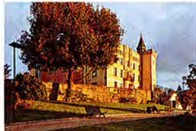
Usine des eaux, Caluire-et-Cuire
