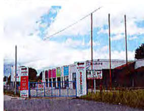
Des préenseignes et enseignes qui subsistent après le départ de l'activité. On note également trois poteaux (certains destinés à recevoir des dispositifs), reliés par la rouille ainsi que des enseignes sur façade que le soleil a passées.
